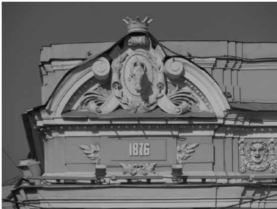
Фрагмент фасада цирка Чинизелли
