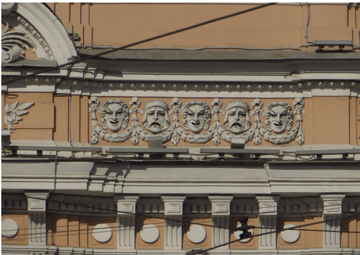
Фрагмент фасада цирка Чинизелли
