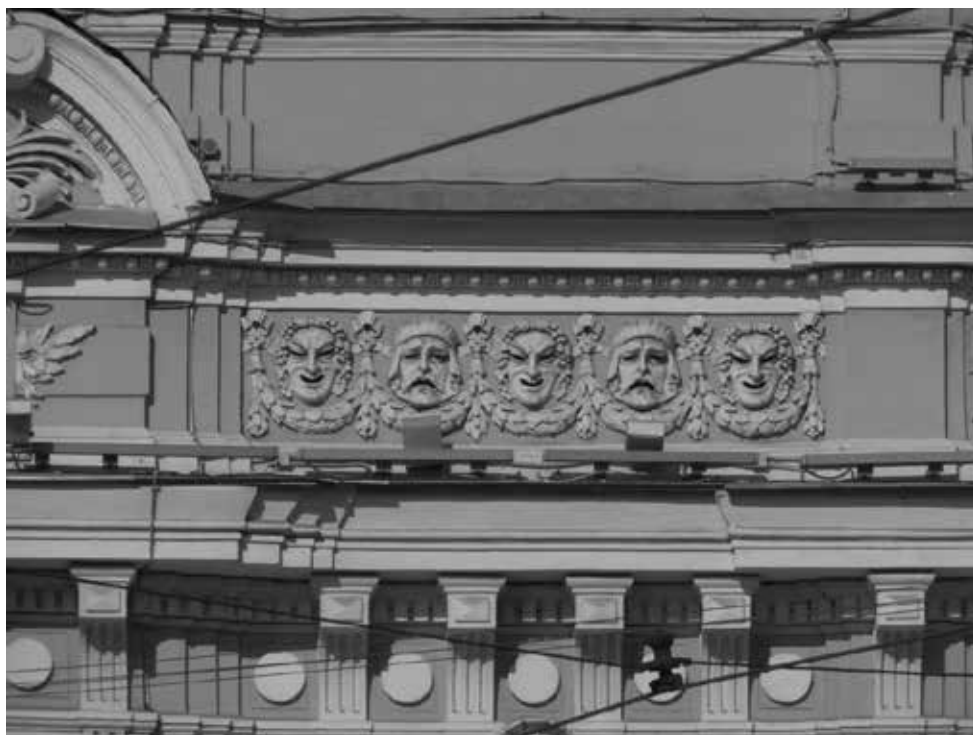
Фрагмент фасада цирка Чинизелли
